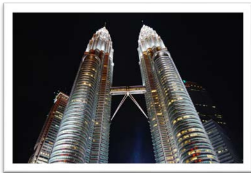
クアラルンプール：ツインタワー
