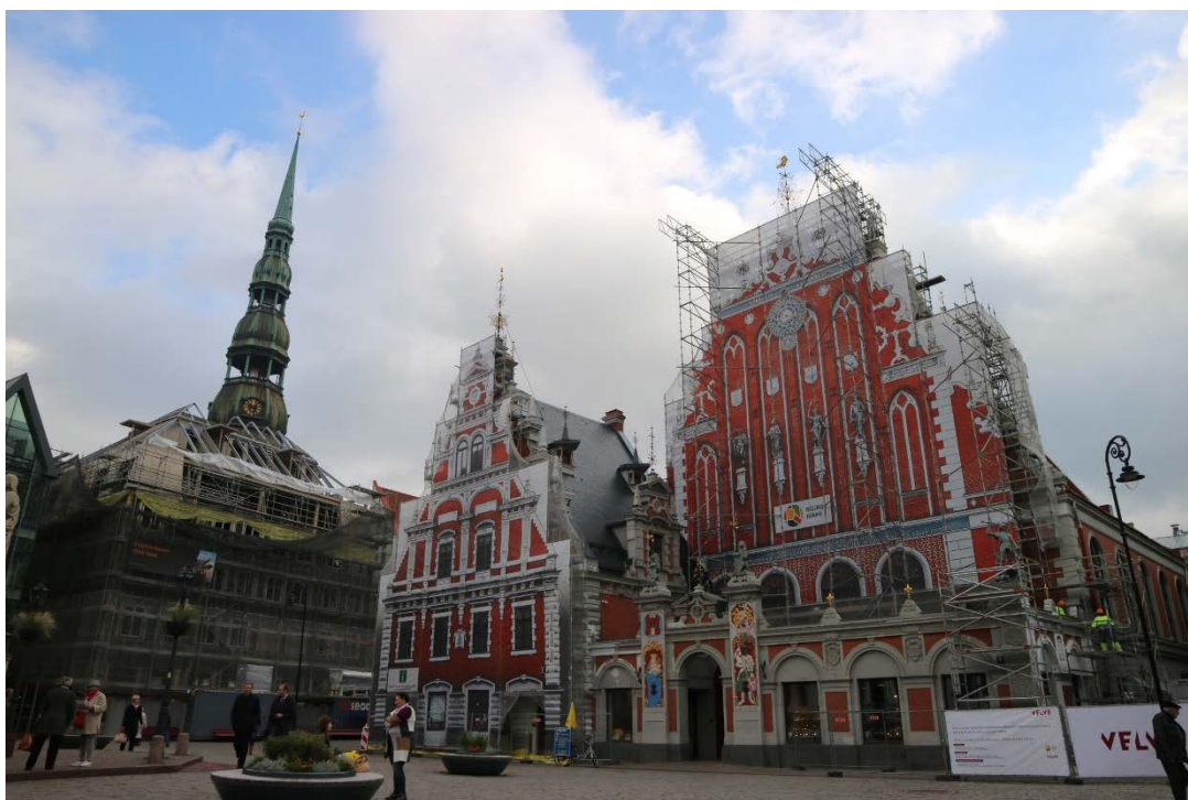
工事中のブラックヘッドハウス。ダミーでした。
